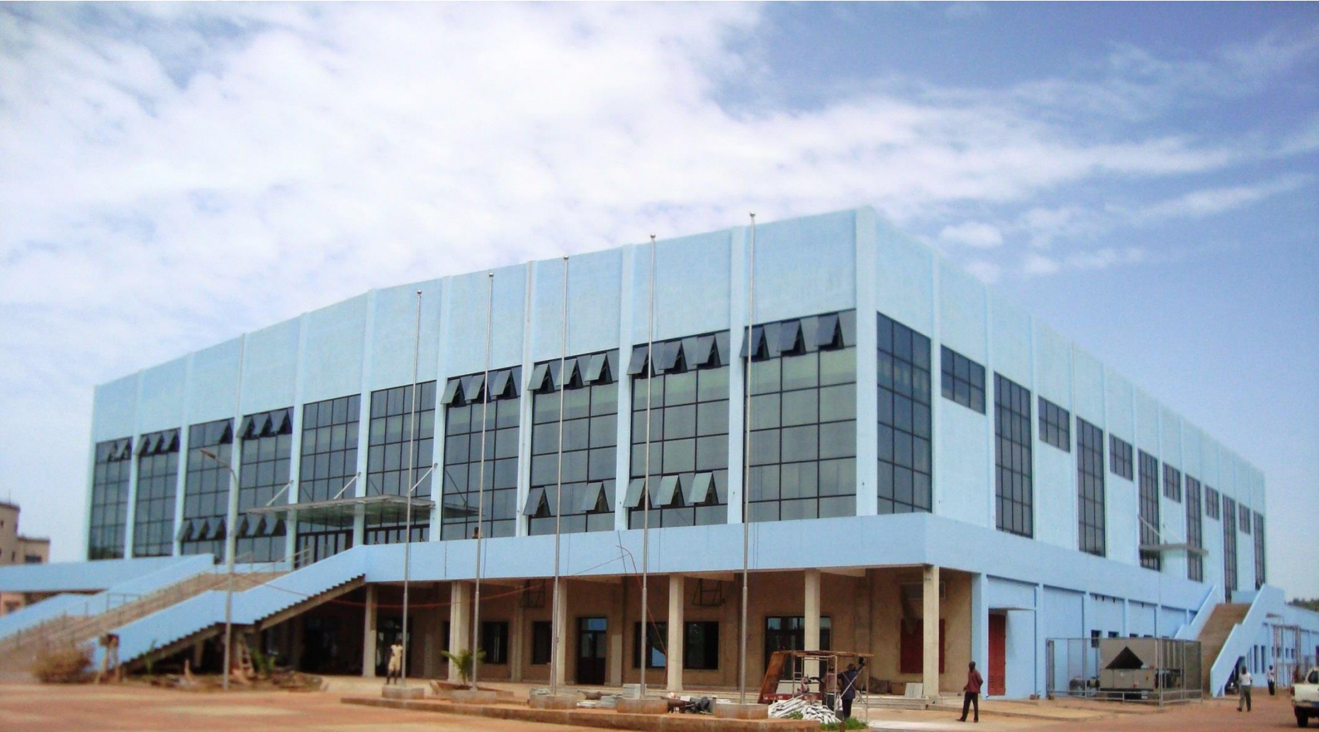
Figure 13: Le Palais des Sports en chantier
